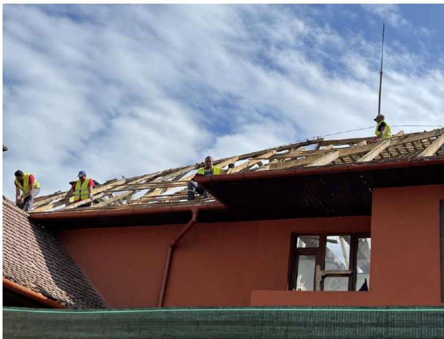
Lucrări la acoperișul căminului cultural din Ibănești Sat
