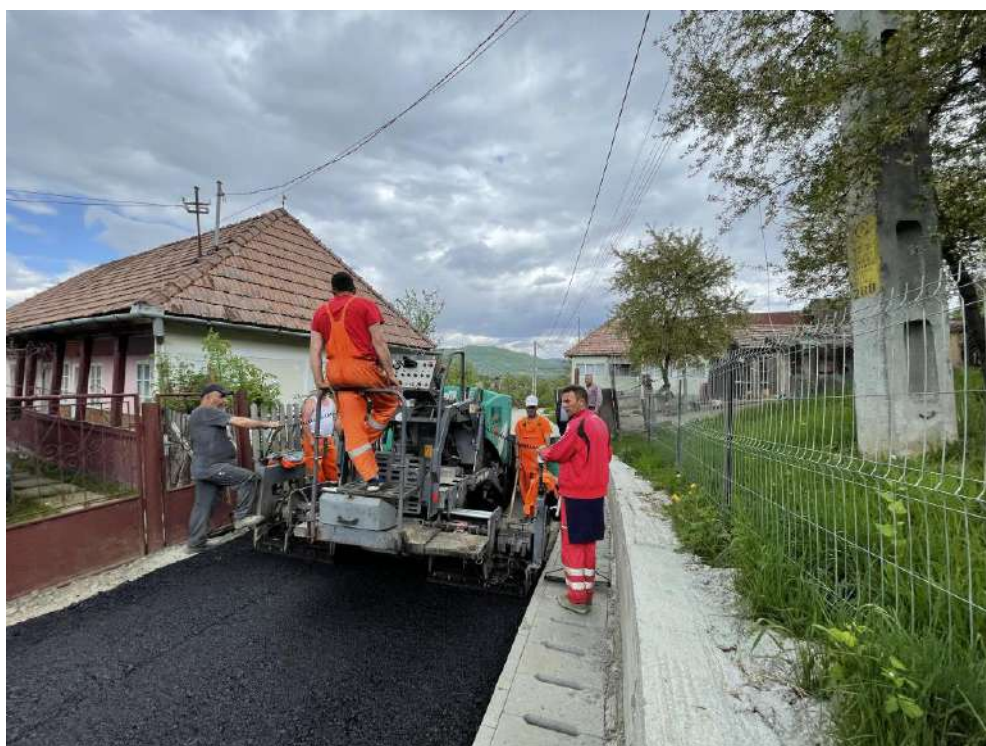
Lucrări de asfaltare în Ibănești Sat
