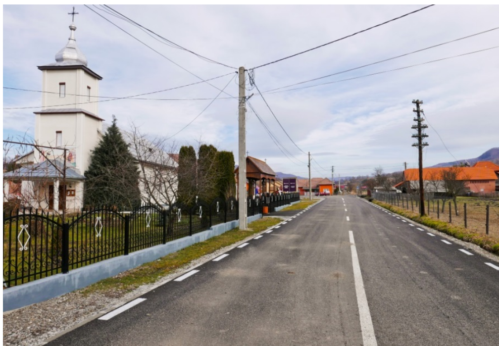
Șosea asfaltată din Isticeu, zonă în care lucrările vor continua.
